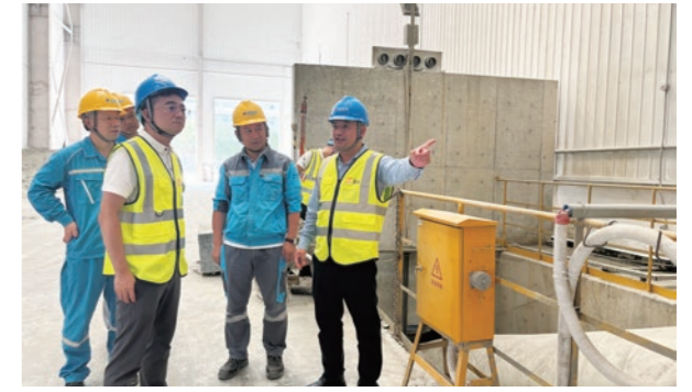
江门智筑开展 EHS 检查
