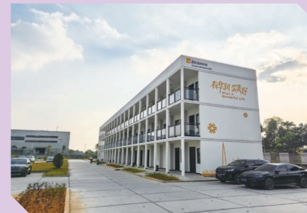
定安智筑科技为员工建设新宿舍
