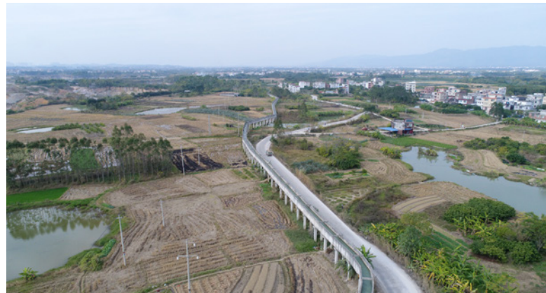
平南水泥修建的惠民排水渠
