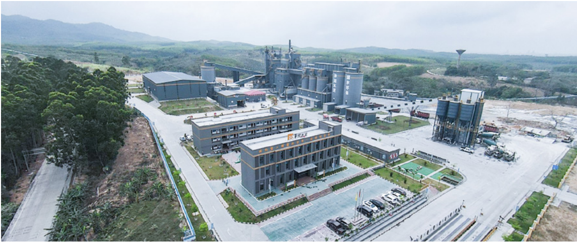
海南昌江建筑垃圾消纳场项目
