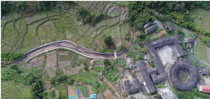
永定水泥帮助虞溪村修缮后的水利设施
