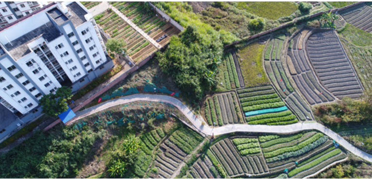
永定水泥与地方政府共同修建的便民通道
